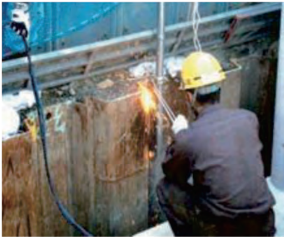
土木工事現場で活躍
