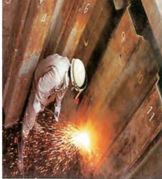
シートパイル溶断
