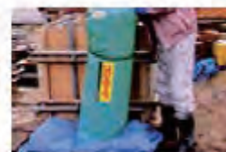
4.養生後筒状にして撤去(折りたたみ不可)
