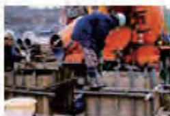
1.コンクリート打設
